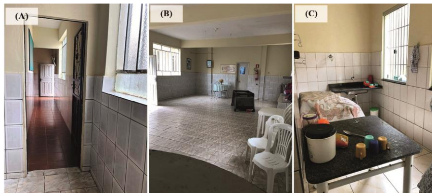
Figura 32 - Iluminação no lado da fachada oeste - (A): corredor de acesso aos quartos; (B): área de “convívio”; e (C) cozinha
