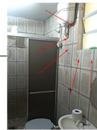
4 - Janela basculante pequena e alta (Banheiro)
