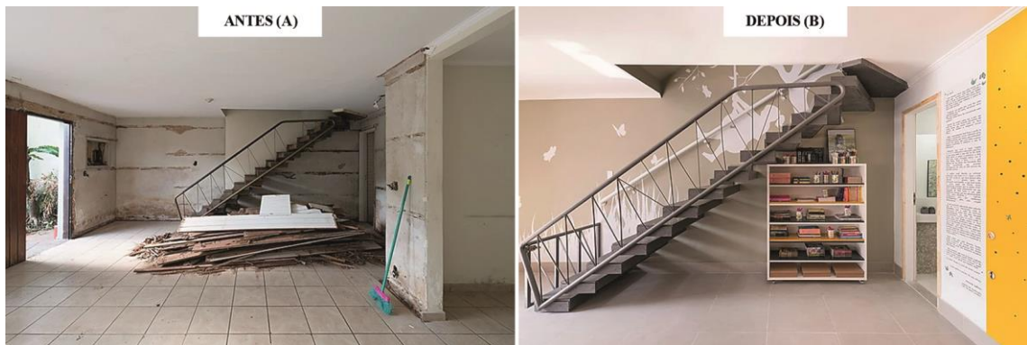
Figura 14 – Fotos da escada (A): antes da reforma - escada deteriorada e espaço inferior mal aproveitado; e (B): depois da reforma - instalação de estante debaixo da escada
