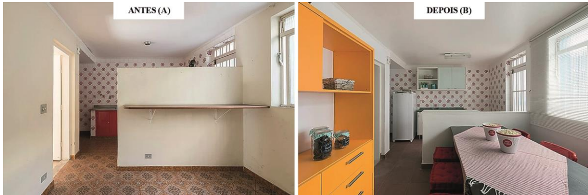
Figura 19 – Fotos da cozinha (A): antes da reforma, sem ligação com a copa; e (B): depois da reforma, mais aberta e com ligação com a copa
