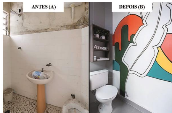
Figura 2117 - Fotos do banheiro da edícula – (A): antes da reforma, inacabado; e (B): depois da reforma, com arte e novas cores
