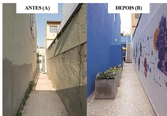
Figura 13 – Fotos do corredor - (A): antes da reforma; (B): depois da reforma mais amplo, colorido e aconchegante
