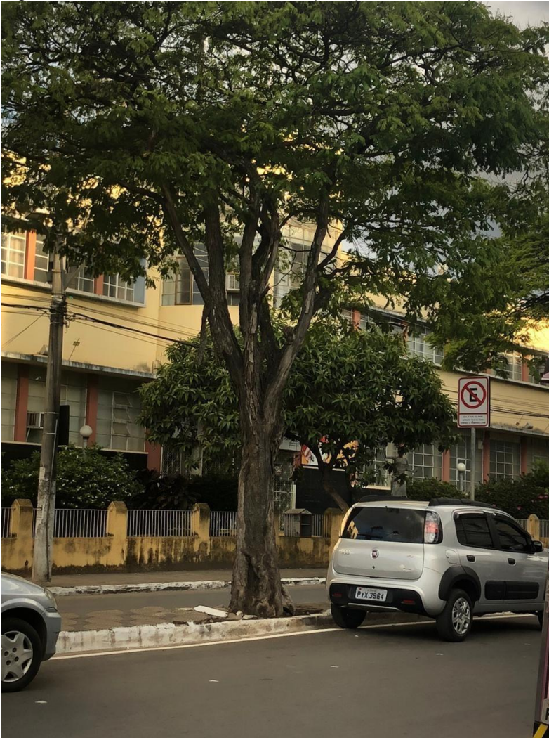
Figura 26: canteiro central danificado pelo plantio inadequado na Av. Moacir de Matos
