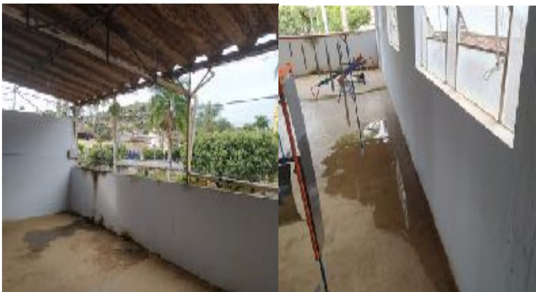
Imagem 27- Mureta da Fachada Principal e Piso
