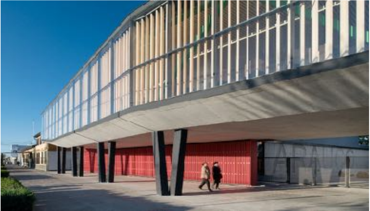
Imagem 8 – Fachada do Centro Cultural
