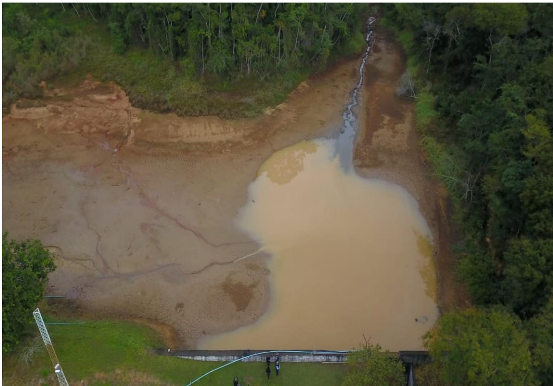
Figura 2 - ETA Maravilha em São José do Vale do Rio Preto, RJ, opera com volume morto:
