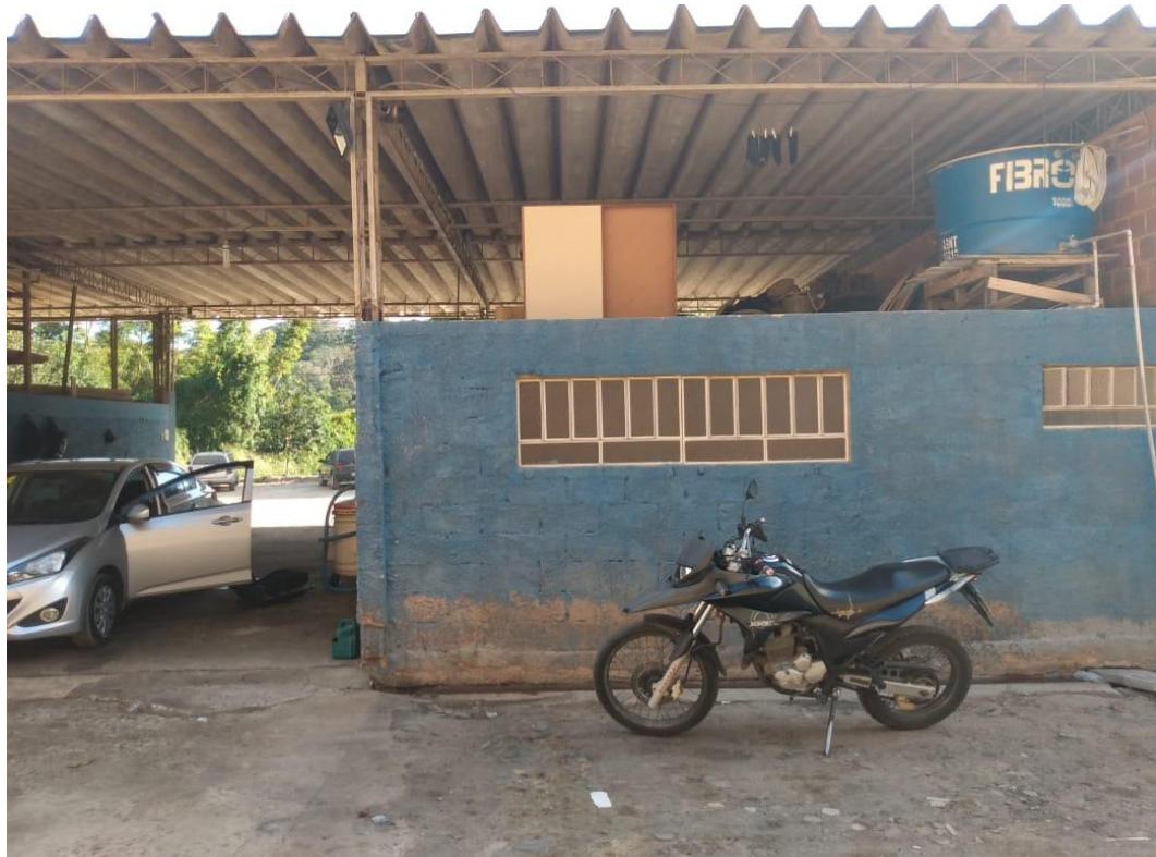
Figura 8: Área de Instalação dos Reservatórios
