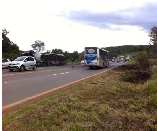
Figura 9: Pista de rolamento a esquerda sentido Juiz de Fora x Belo Horizonte
