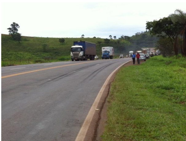
Figura 8: Pista de rolamento a direita sentido Belo Horizonte x Juiz de Fora
