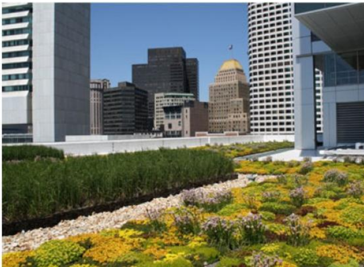
Figura 7 - Cobertura semi-intensiva em edificação em Indianápolis, EUA
