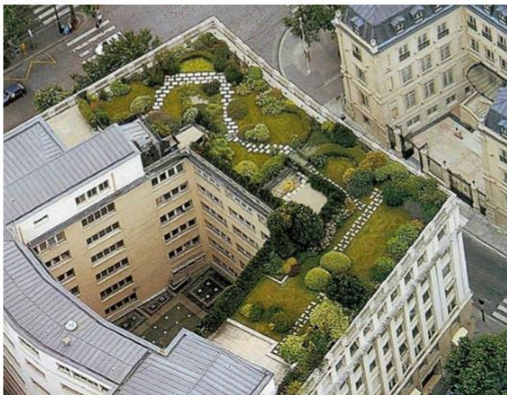
Figura 6 - Cobertura Verde Intensiva
