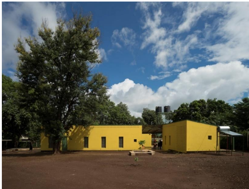
Figura 30 – Casa Albergue KWIECO
