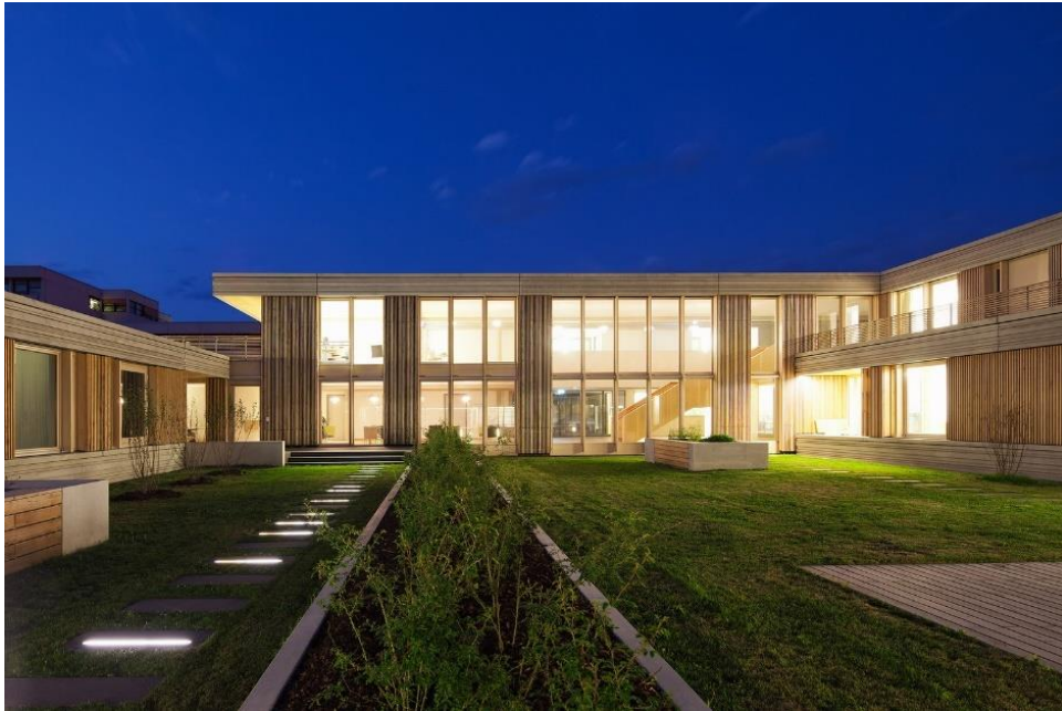
Figura 28 – Centro Psiquiátrico Friedrichshafen, vista do pátio central
