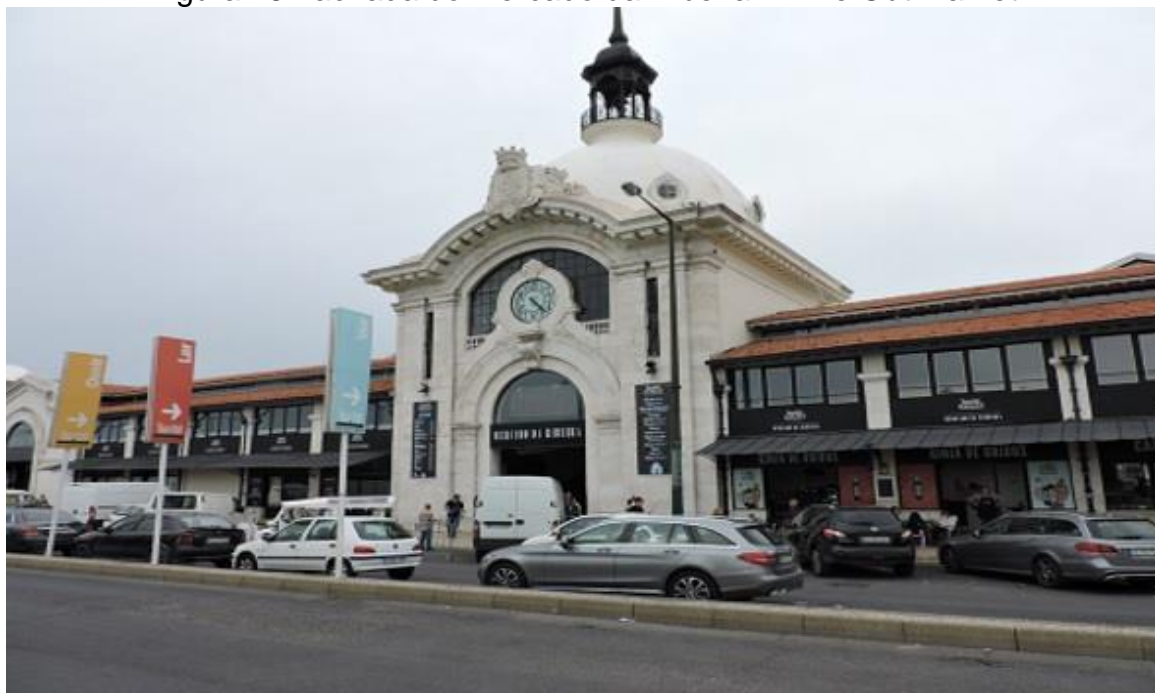
Figura 26: Fachada do Mercado da Ribeira - Time Out Market.
