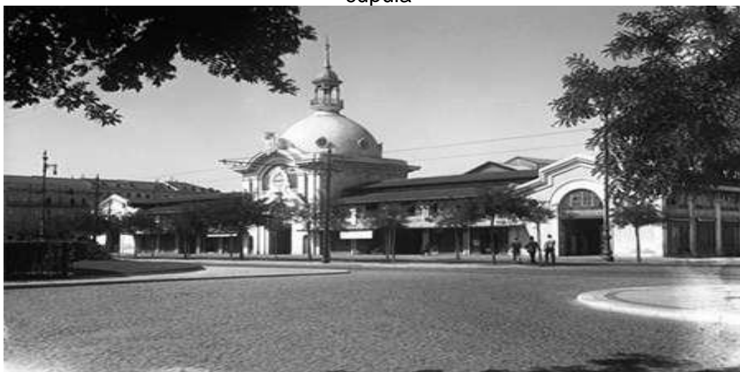
Figura 20: Fotografia da edificação do Mercado da Ribeira com o acréscimo da cúpula
