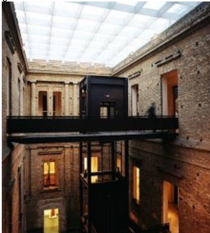
Figura 13: Parte interna da Pinacoteca de São Paulo.
