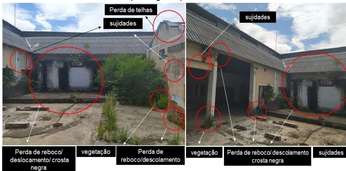
Figura 55: Fotografia de outras fachadas da antiga fábrica com a indicação de suas patologias aparentes.
