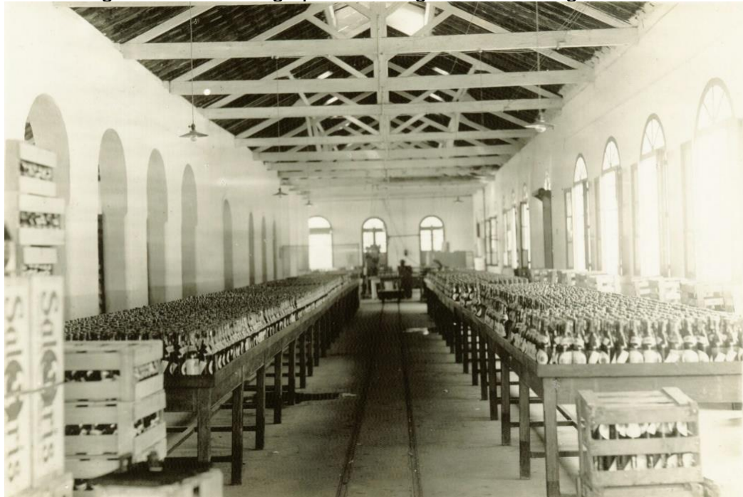
Figura 52: Fotografia interna do galpão da antiga fábrica de águas Minerais Salutaris.
