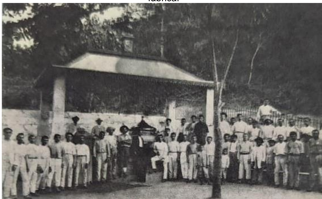
Figura 32: Fotografia de antigos funcionários da empresa Salutaris em frente ao fontanário do Parque Salutaris, quando ainda era localizado atrás do galpão da fábrica.
