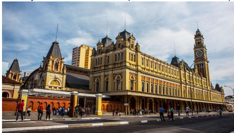
Figura 19: Estação da Luz em 2014, depois do acréscimo do 3º pavimento
