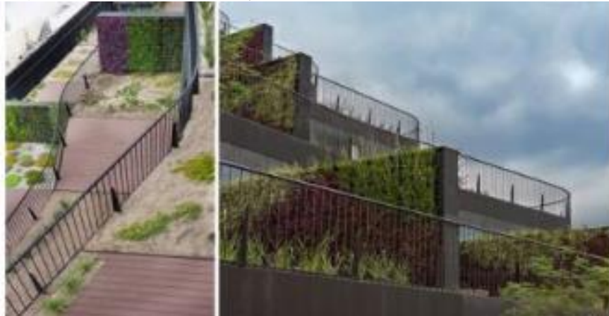
Figuras 56 e 57: Vegetação que compõe o edifício Hing Park
