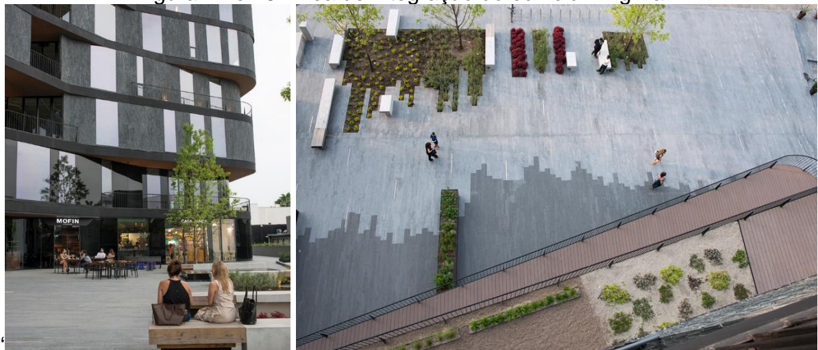
Figura 47 e 48: Área de integração do edifício Hing Park
