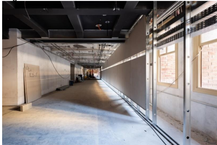
Figura 26: Fechamento das aberturas da fachada
