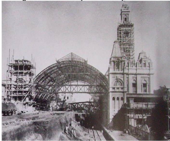
Figura 15: Construção da Estação da Luz
