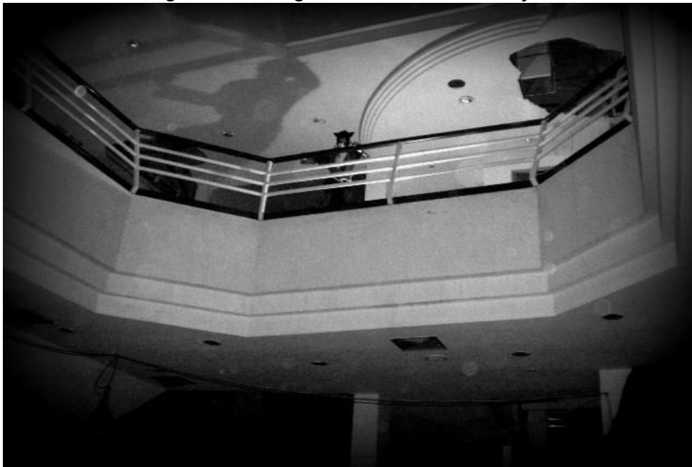
Figura 92: Imagem Interna da edificação
