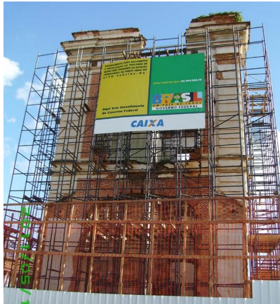
Figura 08: Torreões da Ferroviária Além Paraíba com escoramento.
