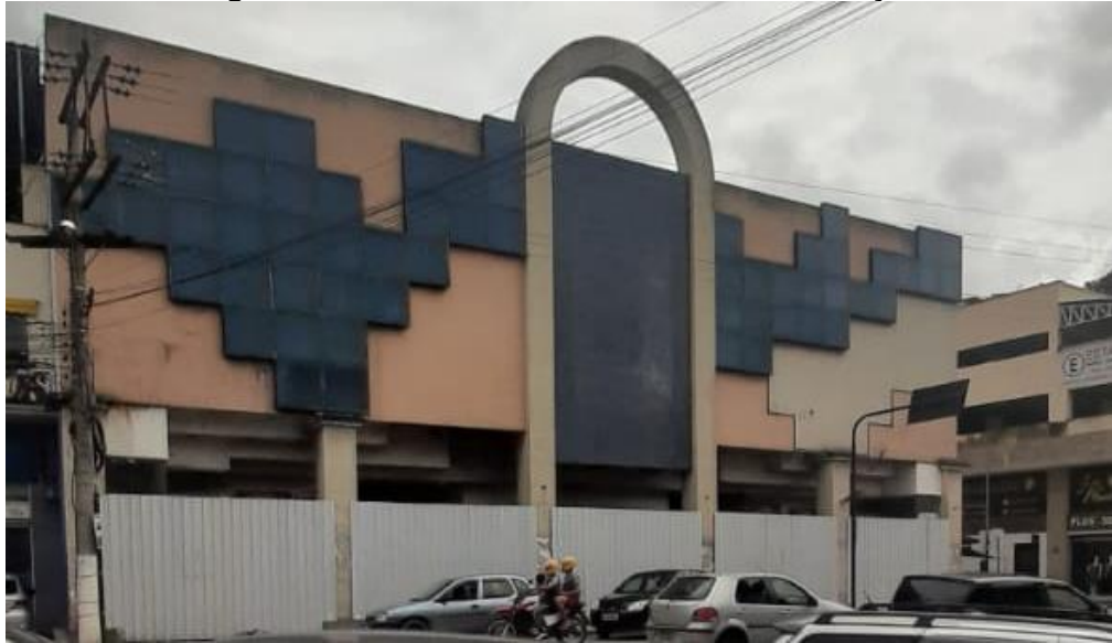
Figura 81: Isolamento ao acesso da edificação
