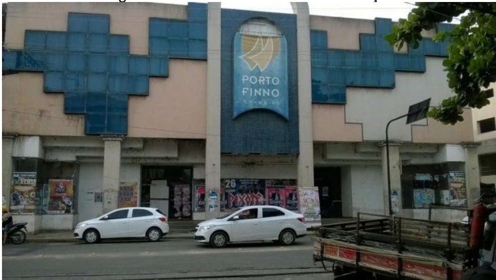
Figura 01: Fachada Frontal da edificação
