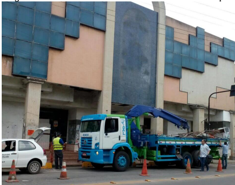
Figura 82: Retirada do letreiro da fachada da edificação
