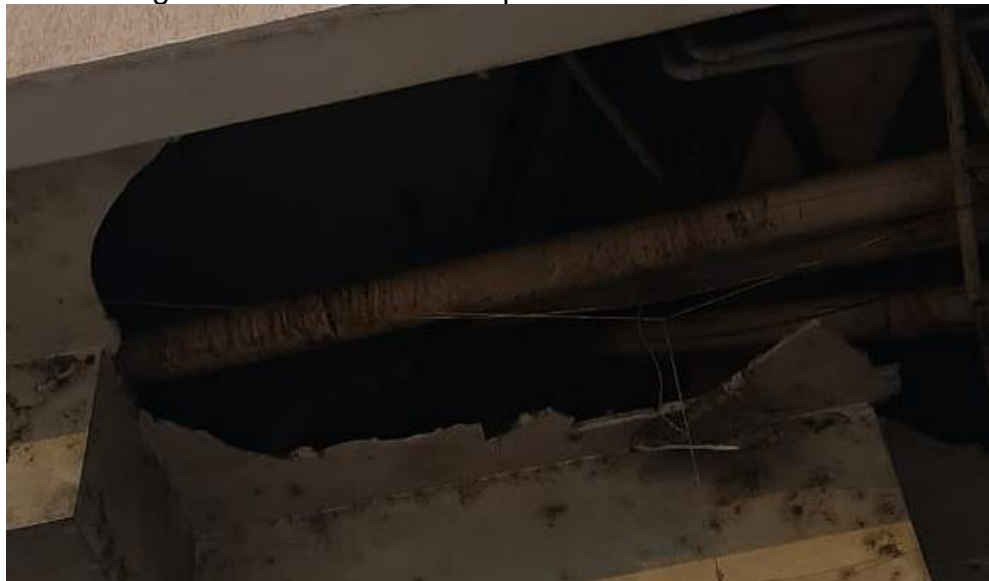
Figura 80: Encanamento aparente na fachada frontal
