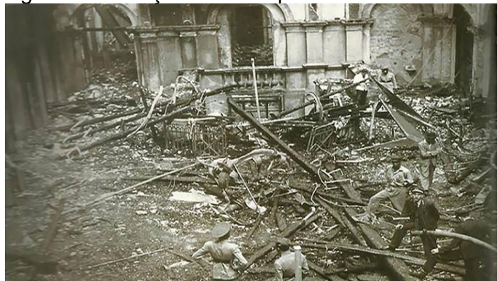
Figura 17: Estação da Luz após o incêndio de 1946
