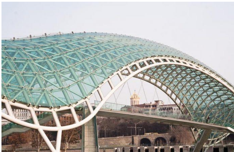
Figura 2. Estrutura metálica - Peace Bridge – Georgia (Alberto, 2017).
