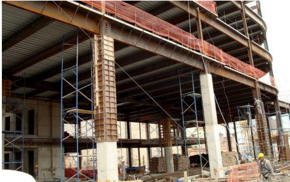
Figura 3. Estrutura mista de aço/concreto (Santos, 2017).
