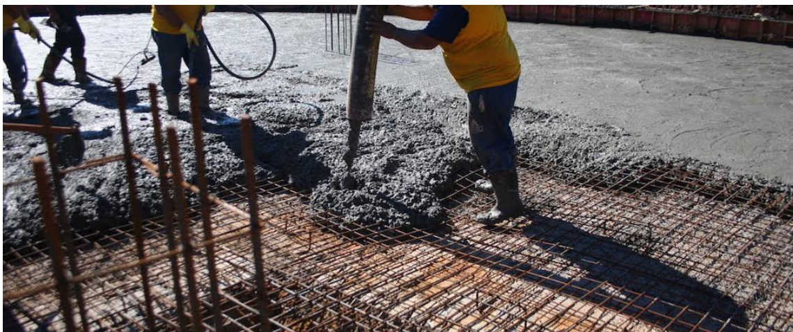
Figura 1. Estrutura em concreto armado (South, 2016).
