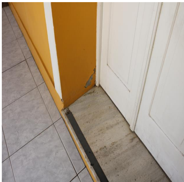
(c) Entrada interna da recepção
