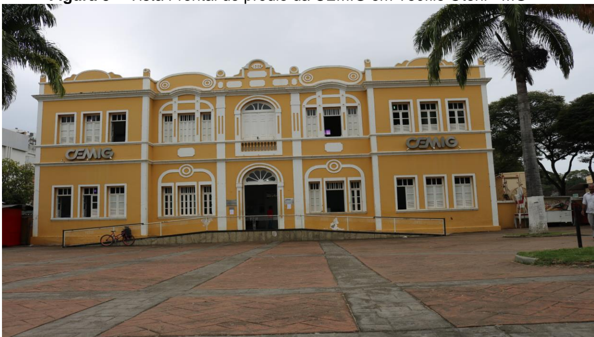
Figura 3 – Vista Frontal do prédio da CEMIG em Teófilo Otoni - MG
