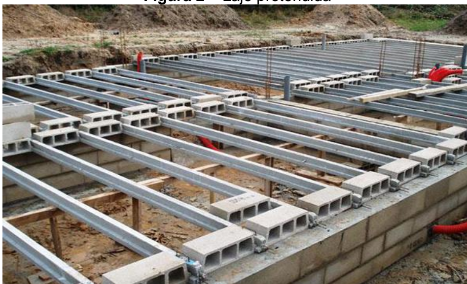
Figura 2 – Laje protendida
