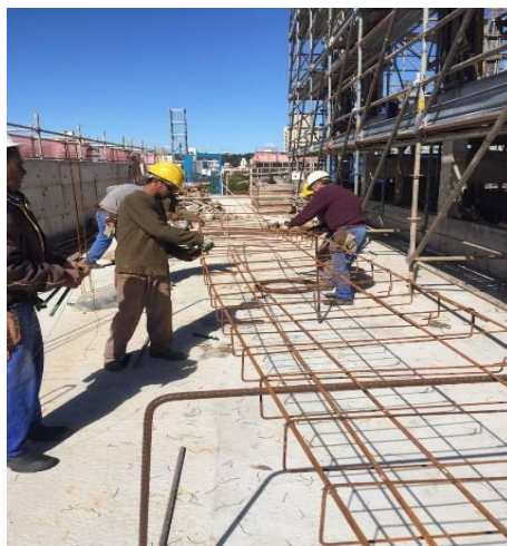
Figura 6 – Montagem das armaduras
