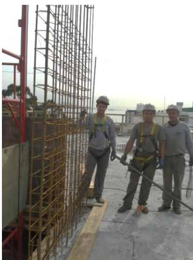
Figura 7 – Armadura montada e posicionada no local destinado
