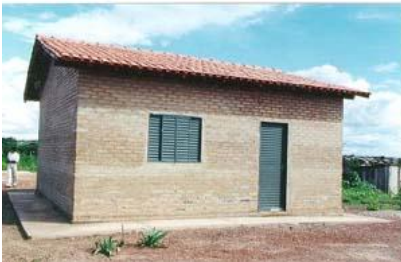
Figura 2- HIS feita com tijolos de solo-cimento em Cuiabá-MT
