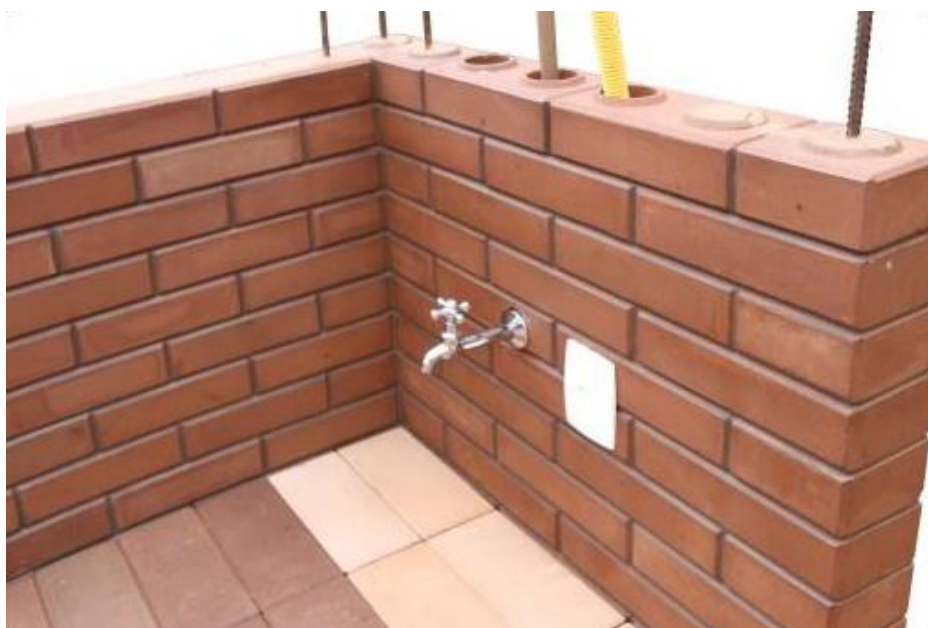
Figura 11 - Instalações e ferragens embutidas no tijolo solo-cimento
