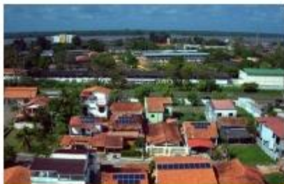
Condomínio Belém . PA
